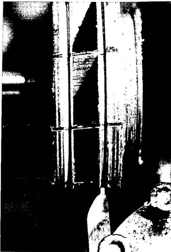
Nach Abdrehen der Scheiben auf Nenndurchmesser werden die äußeren Nuten für die Wicklung eingestochen. Der Breite der inneren Flanke der Nut auf beiden Scheiben entspricht der Kante „K“.
