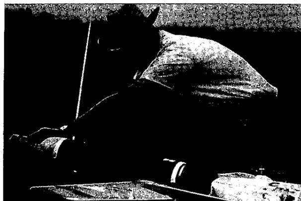
Beim Anlassen des Triebwerkes werden die heißen Abgase sicherheitshalber durch einen Blechkanal unter dem Höhenleitwerk abgeleitet. Die Anlasserluft wird durch die Hauptansaugöffnung eingeblasen. Dabei schließen die Zusatzklappen automatisch. Nach Stabilisierung auf Leerlaufdrehzahl ist der Abgaskanal nicht mehr erforderlich.
