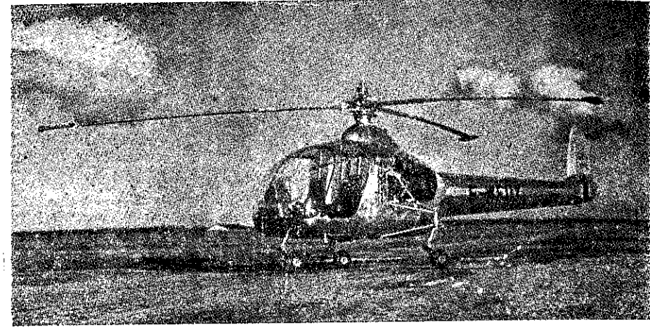
Şekil : 1 — Pal uçlarında basınçlı hava jeti olan, deney SO 1120 - Arı Helikopteri.
