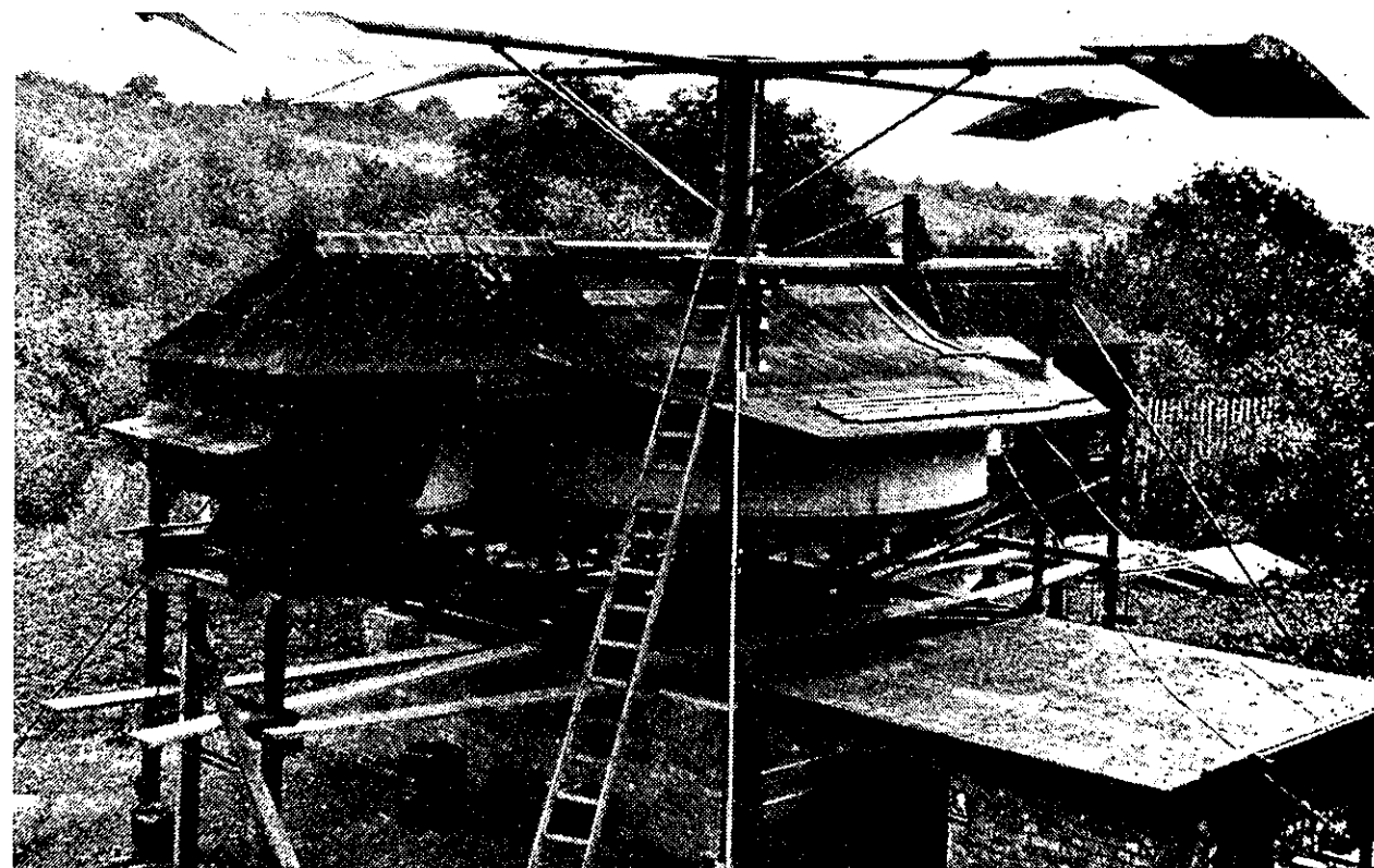
Helmuth Hirth: Rotor-Versuchsstand für einen Kranhubschrauber (1912).
