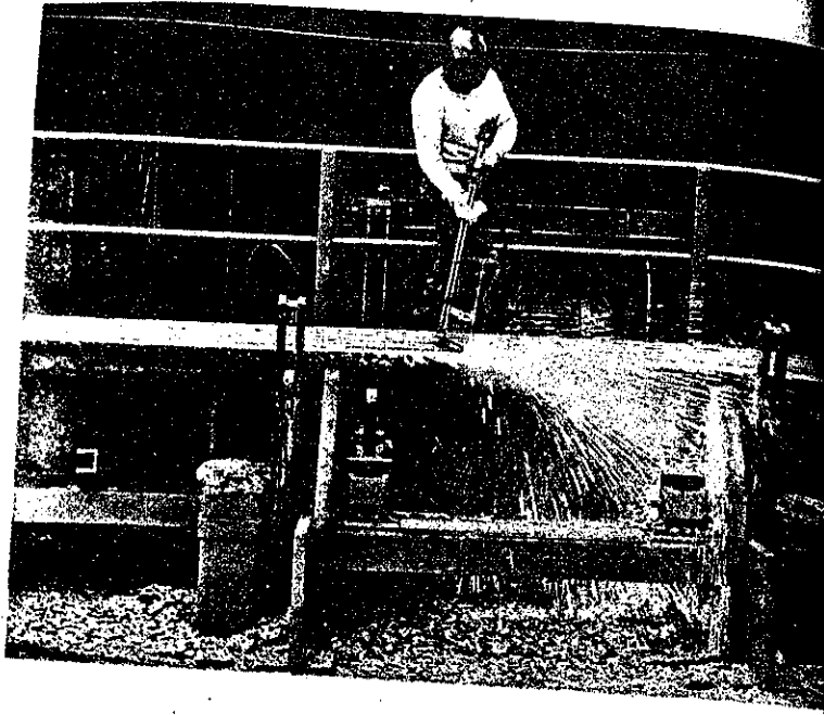
Şekil:11-10 Yüzeydeki artıkların kesilerek temizlenmesi
