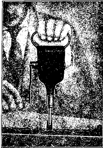
Abb. 20 Matra-Ventil-Einschleifmaschine für Handbetrieb
