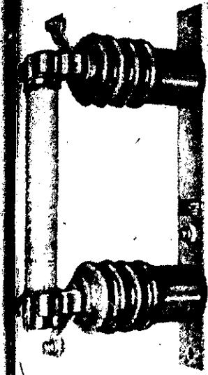
(Şekil : 3-54) a) 15 KV. Y.G. Sigortası, b) Diferansiyel rölenin trafoya bağlanması.
